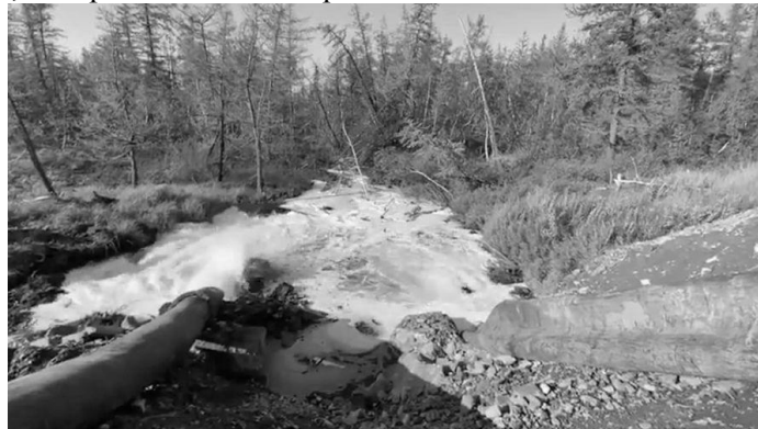
Рисунок 1 – Хвостохранилище Талнахской обогатительной фабрики, сброс жидких отходов в тундру
