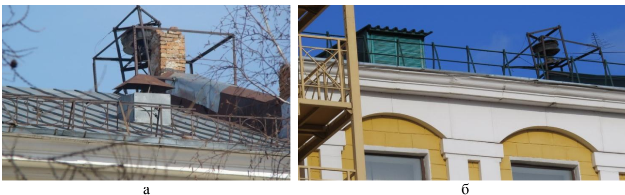
Рисунок 3 – Тур пункта 2 класса плановой сети над зданием медицинского университета (а), и то же здание после ремонта (б)
