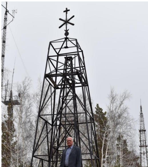
Рисунок 5 – Религиозные символы на простом металлическом сигнале Сопка на Николаевской сопке (а), подгнивший и обрушившийся сигнал пункта Высотина (б)
