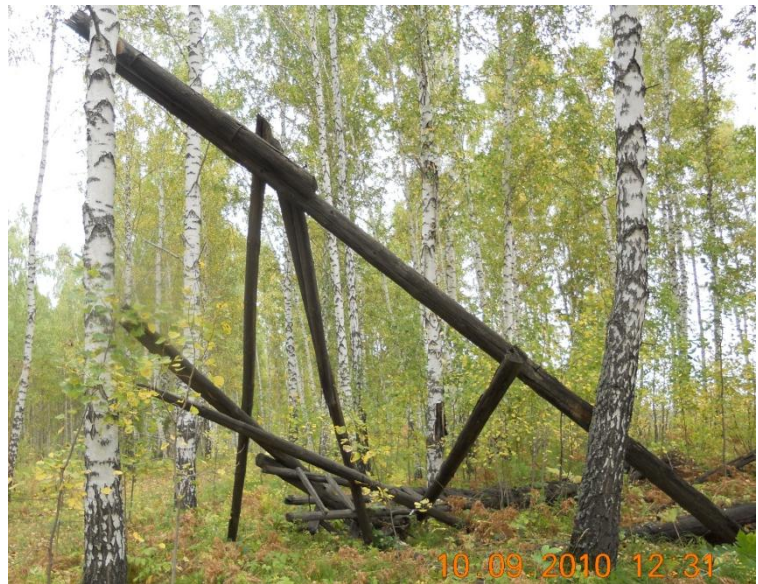
Рисунок 5 – Религиозные символы на простом металлическом сигнале Сопка на Николаевской сопке (а), подгнивший и обрушившийся сигнал пункта Высотина (б)
