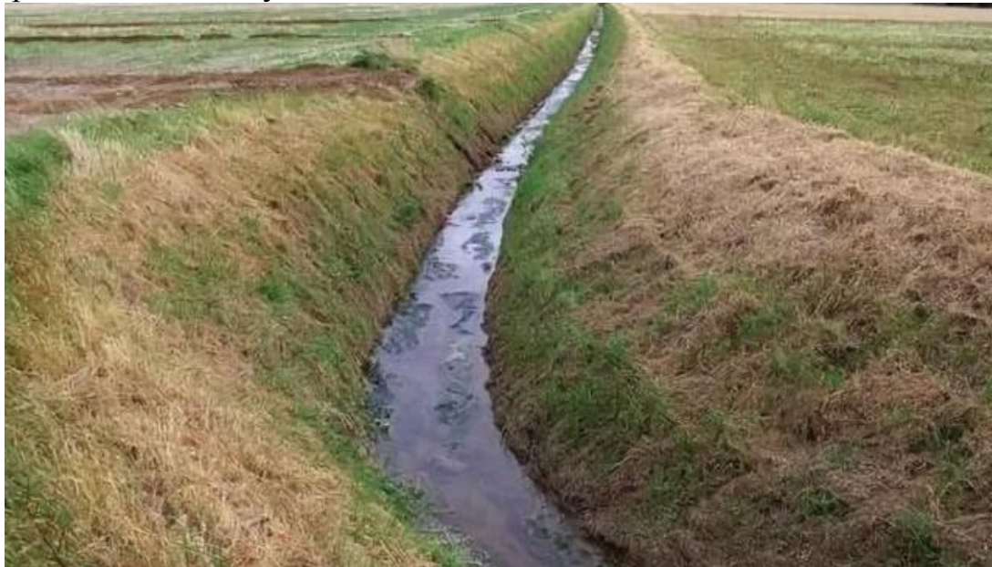
Рисунок 1 – Открытый осушительный канал
