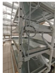
Рисунок 5 – Система циркуляции питательного раствора
