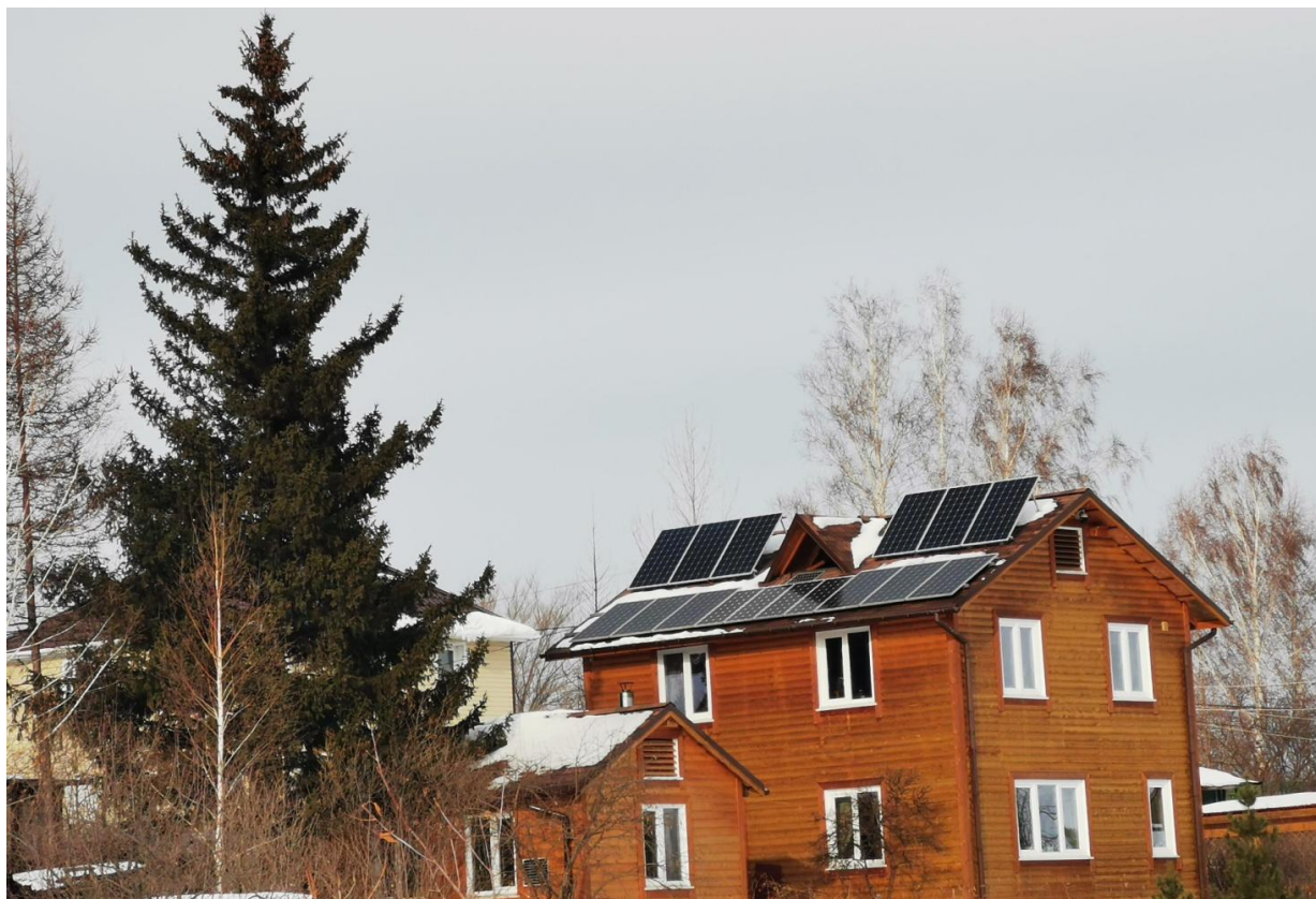
Рисунок 1 – Общий вид усадебного дома с установленными на крыше ФЭМ
