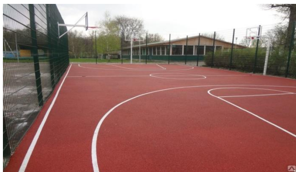
Рисунок 2 – Пример резинового покрытия из EPDM-крошки
