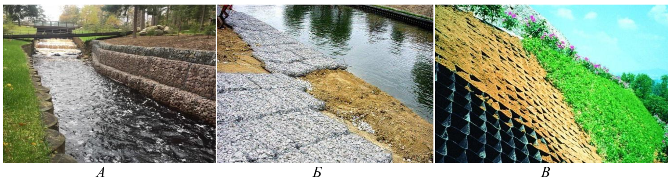
Рисунок 2 – Популярные варианты укрепления берегов (А-габионы, Б-матрацы Рено, В-георешетки)
