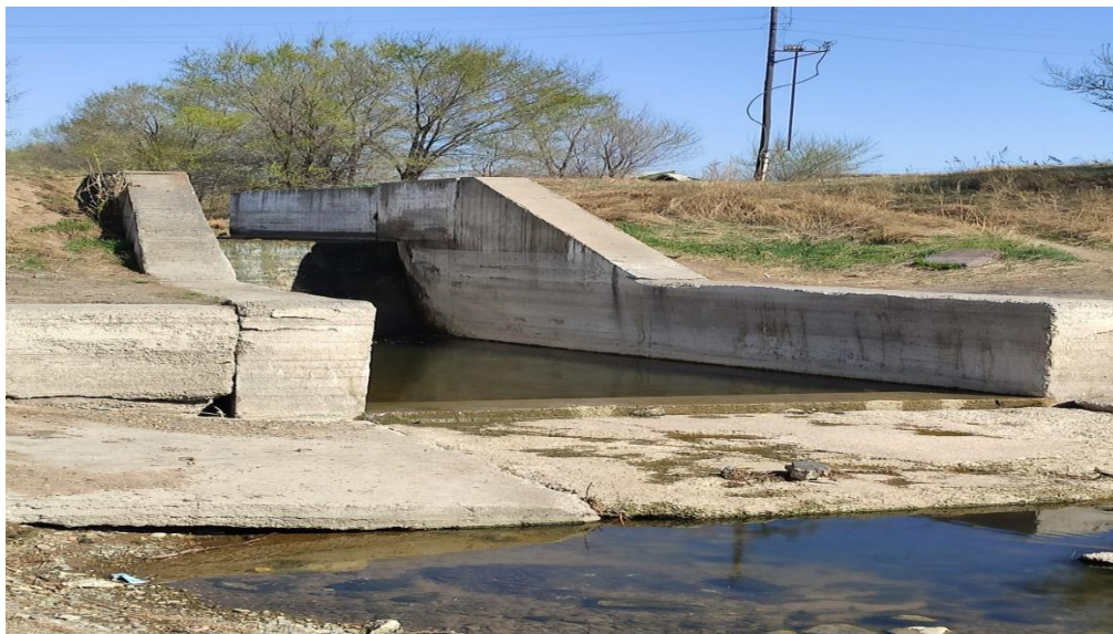
Рисунок 1 - Сбросное сооружение Абаканской оросительной системы
