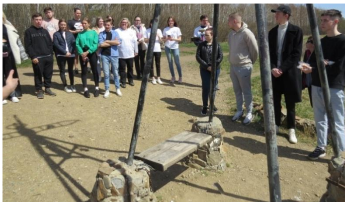
Рисунок 2 – Выявленные нарушения на пункте ГГС 3 класса Дом Отдыха: а – дополнения к визирному барабану; б – декоративная кладка и лавочка
