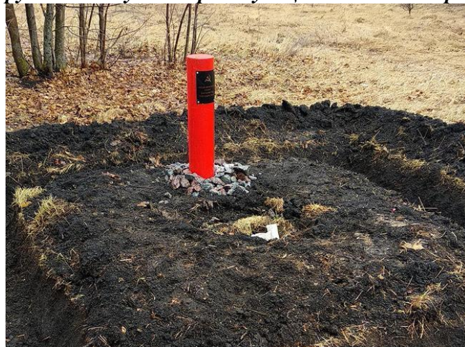
Рисунок 2 - Восстановленный геодезический пункт в Красноярском крае / Фото: Росреестр
