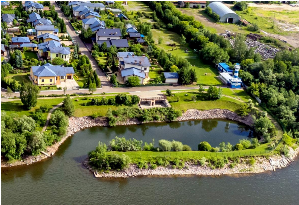
Рисунок 6 – Фотография построенного объекта (2018 г.)
