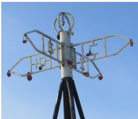
Рисунок 2 – Выявленные нарушения на пункте ГГС 3 класса Дом Отдыха: а – дополнения к визирному барабану; б – декоративная кладка и лавочка
