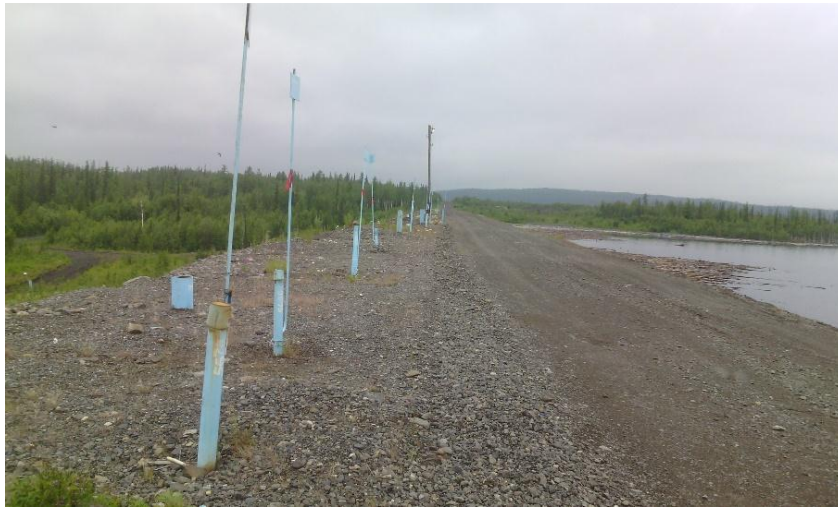
Рисунок 2- Русловая плотина. Верхний бьеф.
