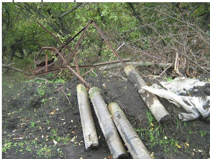
Рисунок 1 - Разрушенный пункт триангуляции / Фото: Росреестр
