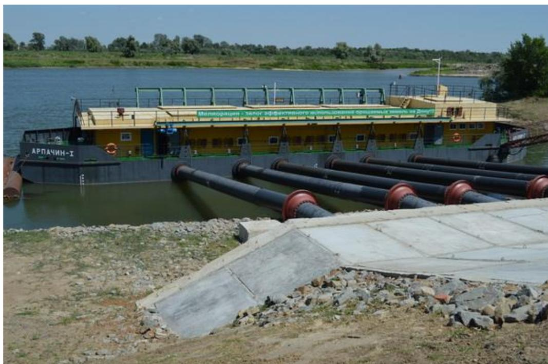
*Рисунок 2 – Плавающая насосная станция «Арпачин – 1»*
