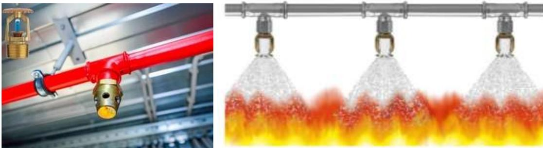
*Рис. 3.5. Спринклерная установка*
