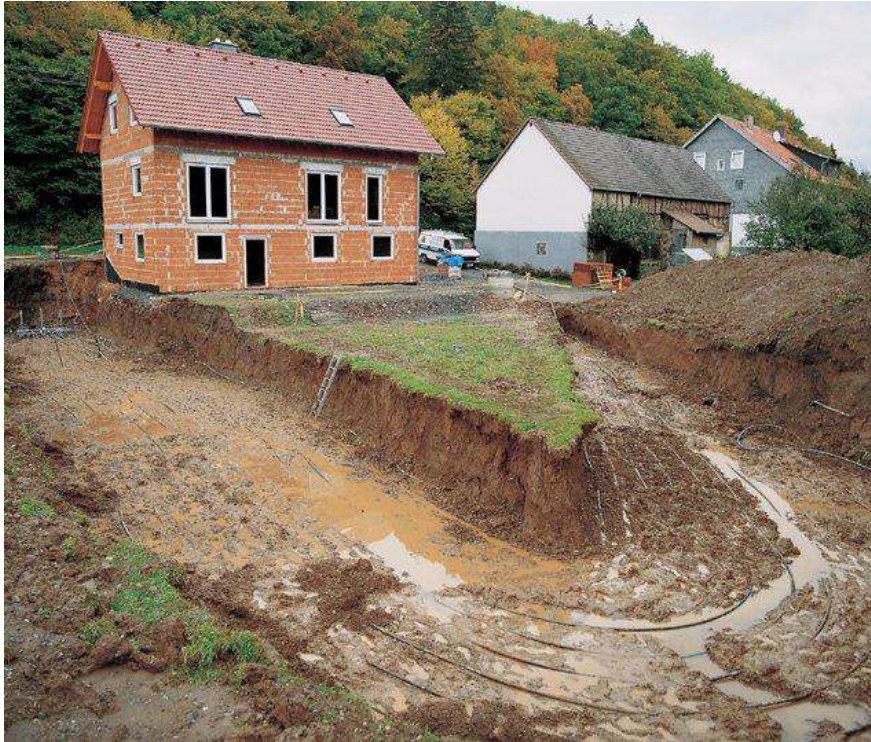
Рисунок 6.6 – Пример монтажа горизонтального грунтового теплообменника на глубине 1,5 м при строительстве нового здания
