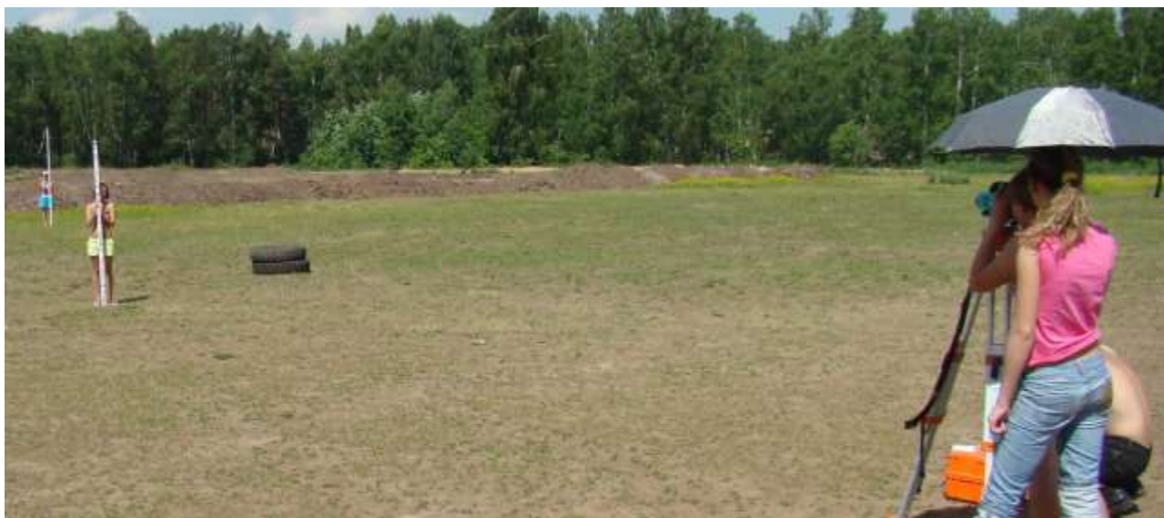
Рисунок 8.6 – Нивелировка строительной площадки объекта недвижимости с участием двух реечников
