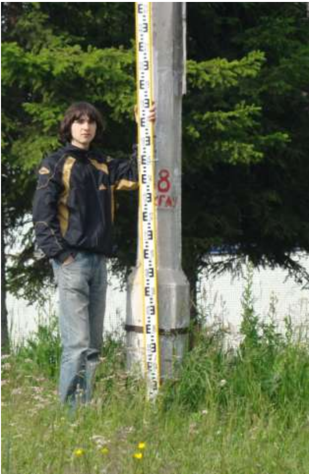
Рисунок 6.7 – Съёмка опоры ЛЭП
