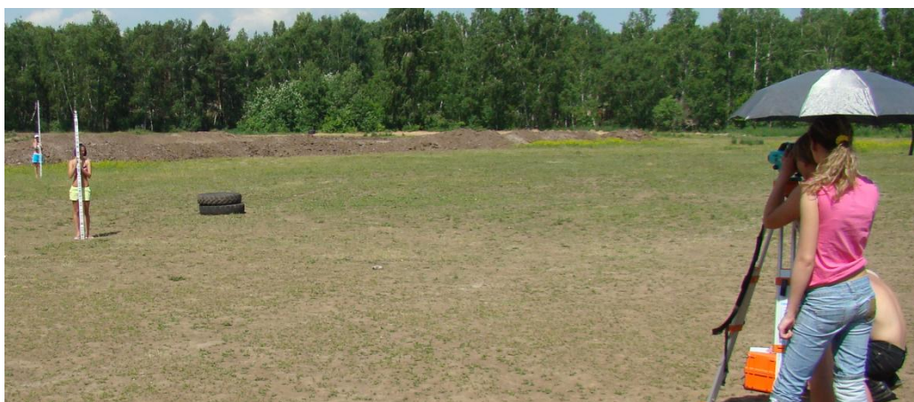
Рисунок 23 – Нивелировка строительной площадки объекта недвижимости с участие двух речников
