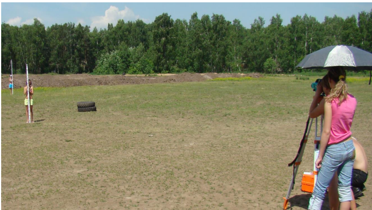
Рисунок 8.6 – Нивелировка строительной площадки с участием двух реечников
