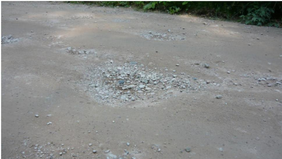
Рисунок 3 – Суффозионные воронки на дороге вдоль ручья Моховой
