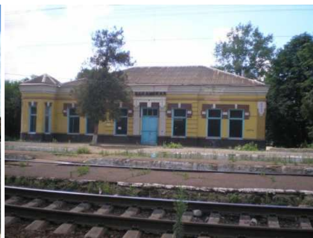
Рисунок 2 – Внешний облик здания железнодорожной станции Баканская
