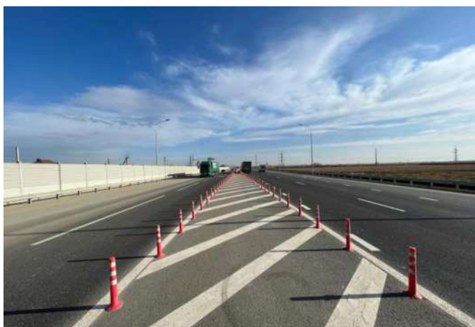
Рисунок 1 – Автомобильная дорога А-146 Краснодар – Верхнебаканский
