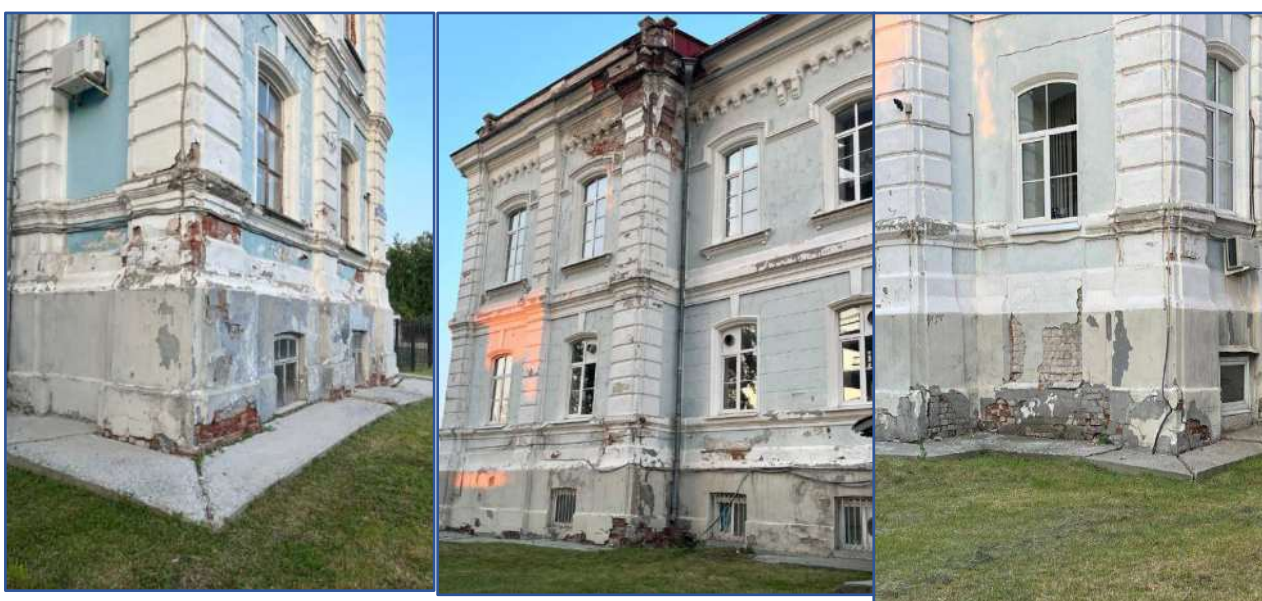
Рисунок 2 – Текущее состояние фасада здания
