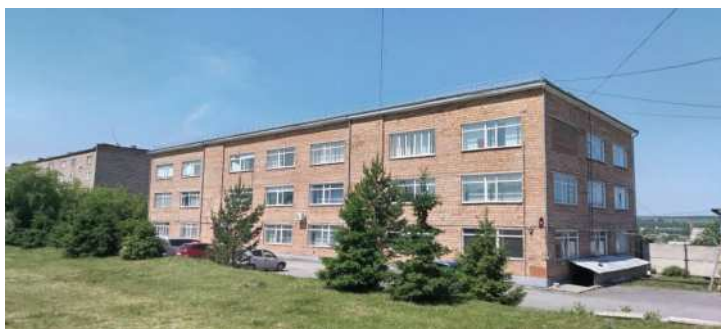
Рисунок 2 – Здание учебного корпуса № 1 Ачинского филиала ФГБОУ ВО Красноярский ГАУ
