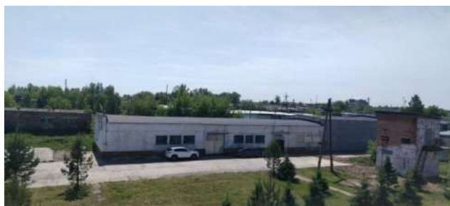
Рисунок 3 – Здание учебного корпуса № 2 (спортзал) Ачинского филиала ФГБОУ ВО Красноярский ГАУ
