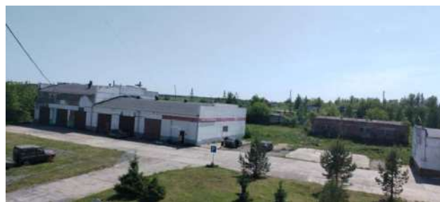
Рисунок 4 – Здание учебного корпуса № 3 (МТП) Ачинского филиала ФГБОУ ВО Красноярский ГАУ
