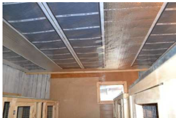
Рисунок 3 – Использование ПЛЭН на основе углеродного напыления в сельскохозяйственных помещениях
