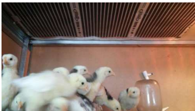
Рисунок 3 – Использование ПЛЭН на основе углеродного напыления в сельскохозяйственных помещениях
